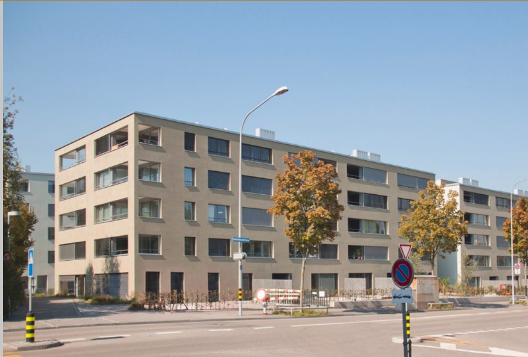
Wohnüberbauung Bachmannweg, Zürich-Affoltern
