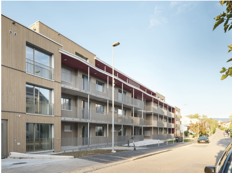
Ersatzneubau Nordfassade mit Laubengang
